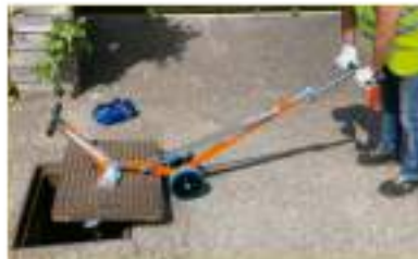
Uso 2: levantamiento con palanca plegable
